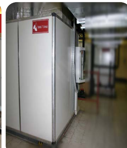
ЖЕСТКАЯ РАМА-ОСНОВАНИЕ МОЩНЫЙ ПРОСТРАНСТВЕННЫЙ КАРКАС ИЗ АЛЮМИНИЯ
